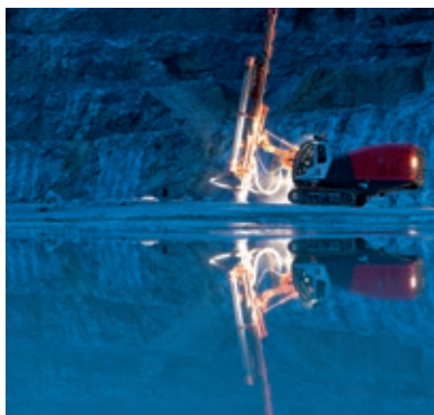
DTH-riggen DI550 i arbete.
